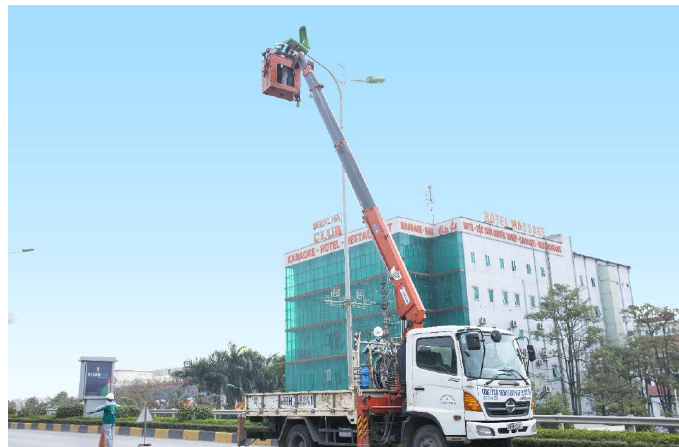
Sửa chữa điện đường phố trên cao
