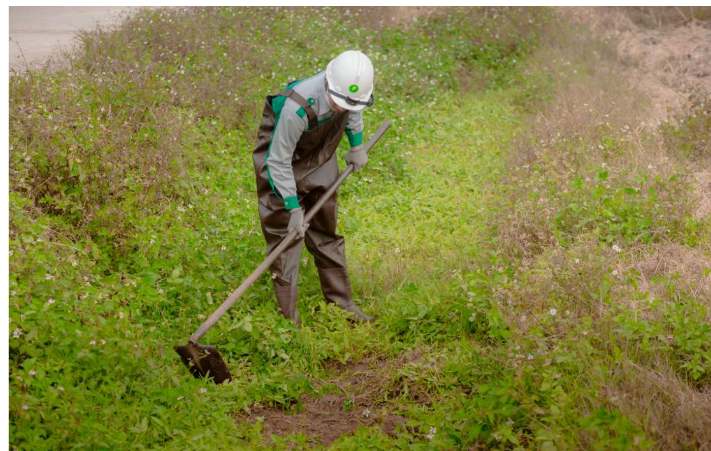
Công nhân nạo vét mương
